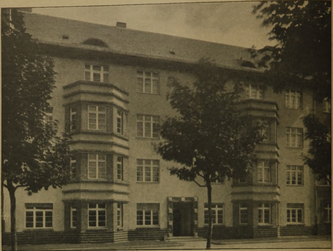
Abb. 1 (oben). Fassade an der Ahrweiler Straße.
