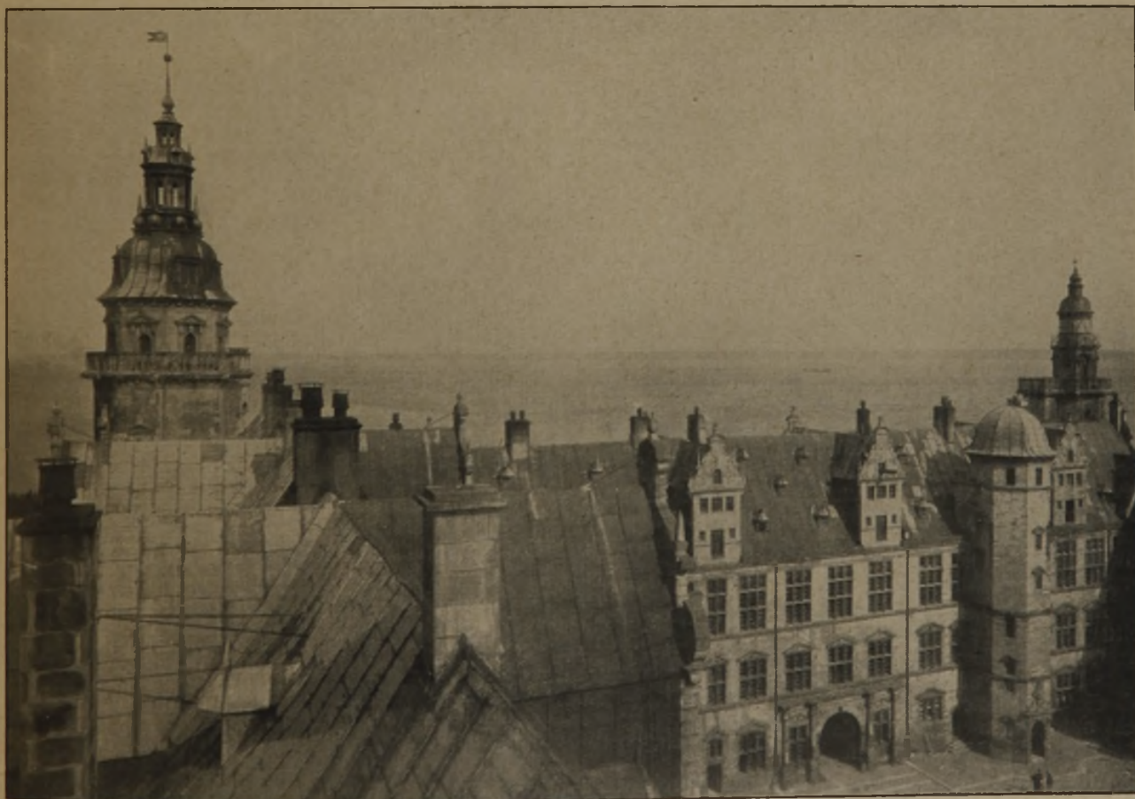
Abb. 15. Schloß Kronborg bei Helsingør (Metalldeckung).
