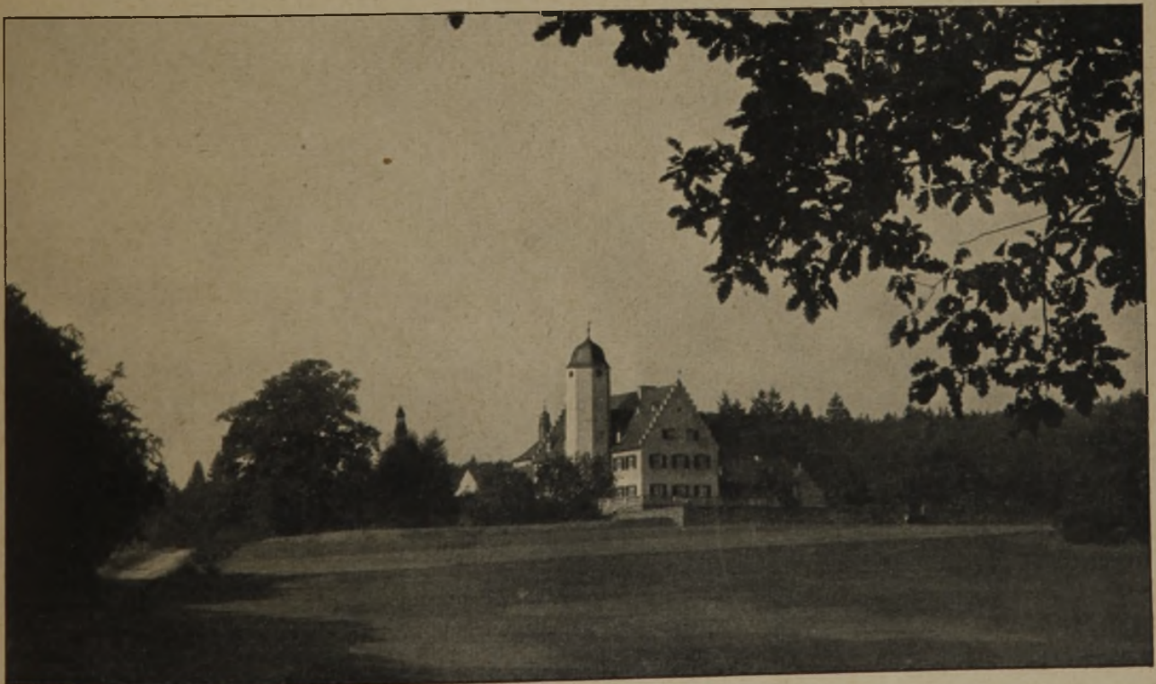
Abb. 1. Gesamtansicht von Osten.
