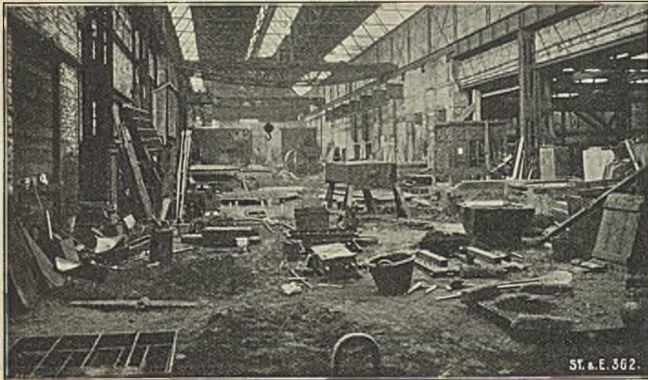
Abbildung 4. Blick in die Laufkranhalle.
