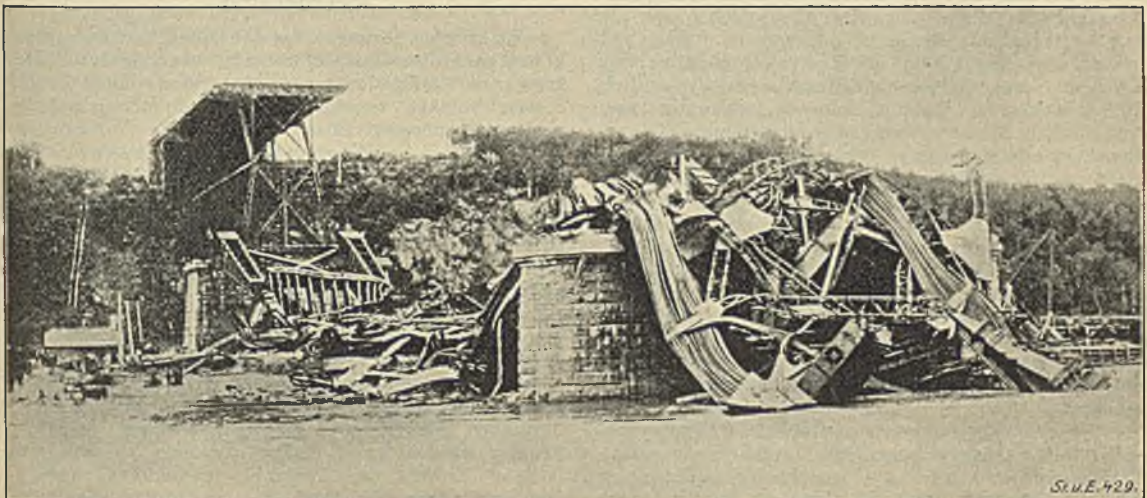
Abbildung 3. Ansicht der eingestürzten Brücke.
