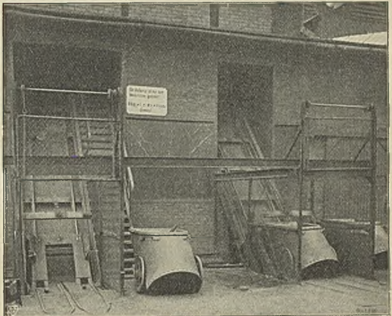
Abbildung 1. Schrägaufzug zu den Kupolöfen in Witkowitz.
