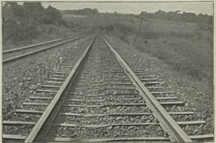
Abbildung 6. Gleise mit Eisenquerschwellen nach einer Entgleisung bei Euclid, Pa.*
