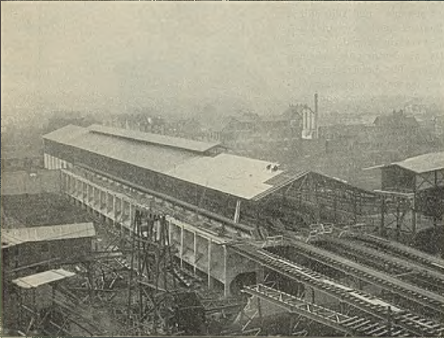
Abbildung 3. Erzsilo im Bau.
