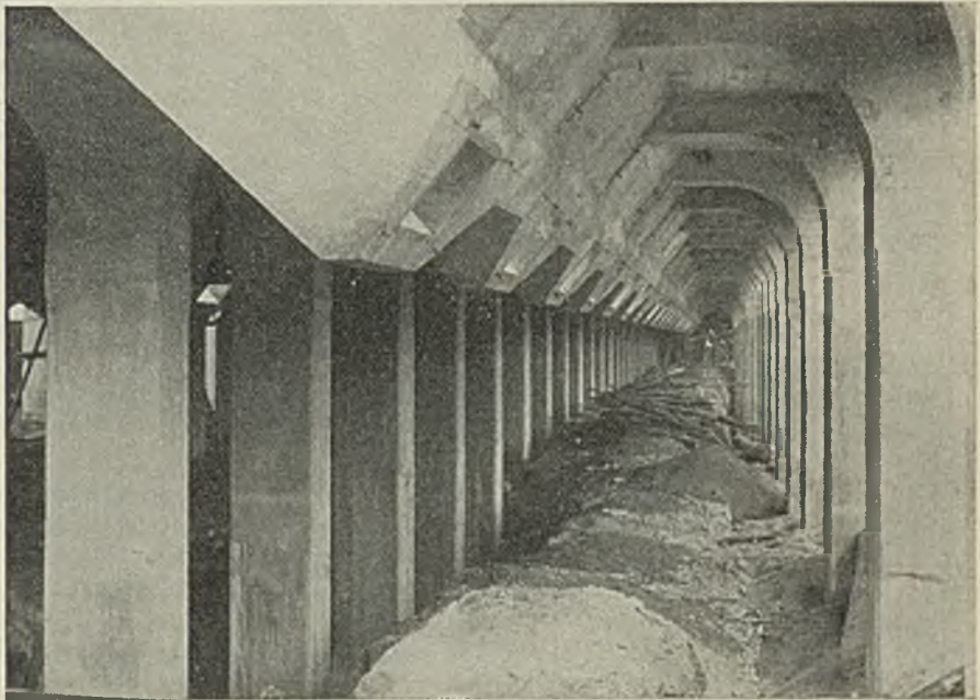
Abbildung 6. Ansicht der Auslauftrichter der Füllrumpfe.
