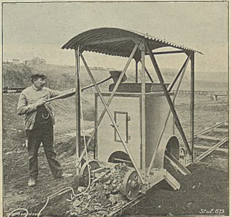
Abbildung 36. Eisenausscheider, System E. H. Geist, Köln.
