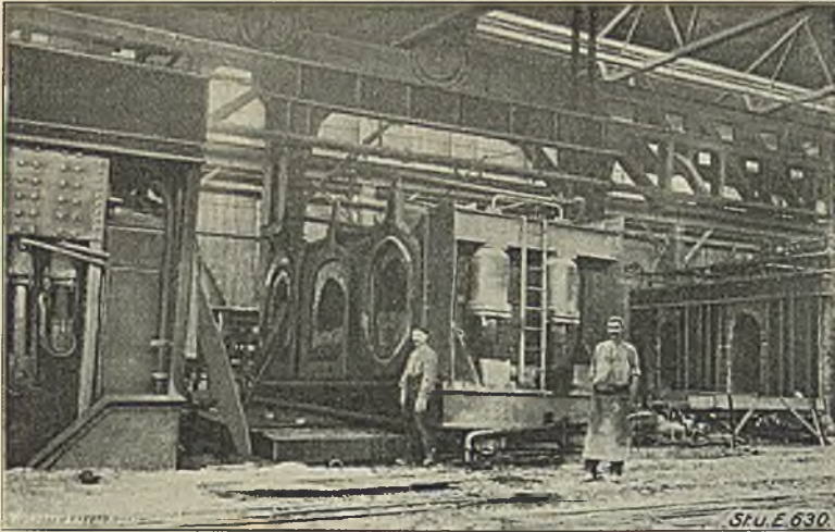
Abbildung 12. Kopf des Talbot-Ofens, zur Reparatur zurückgezogen.
