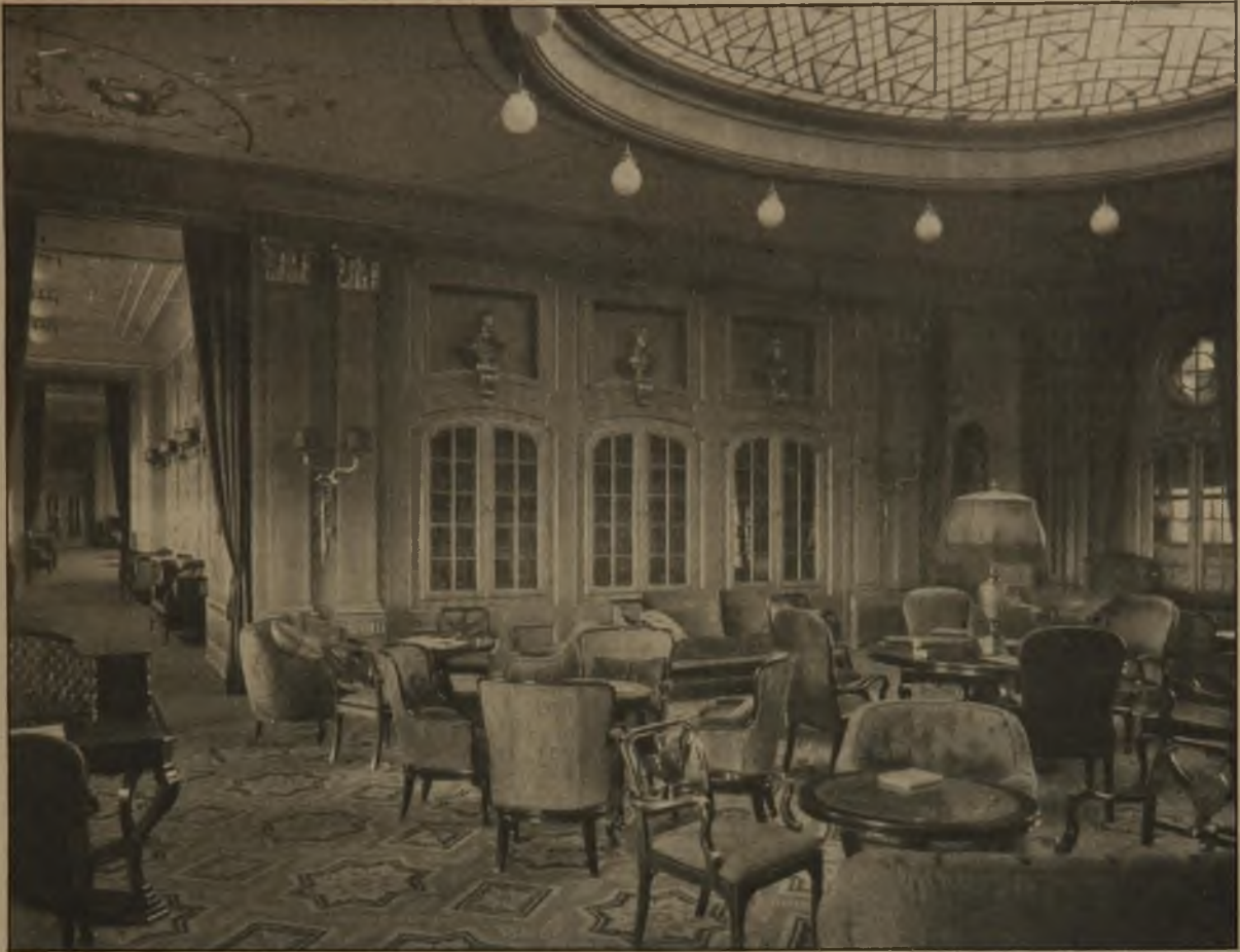
Abb. 4. Dampfer „Columbus“. Blick in die Bibliothek und Verbindungsgang.
