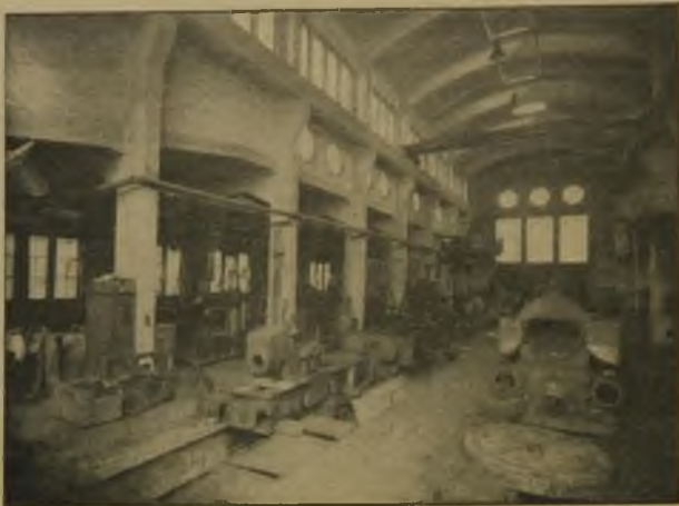
Abb. 7. Montagehalle mit Schlosserei.
