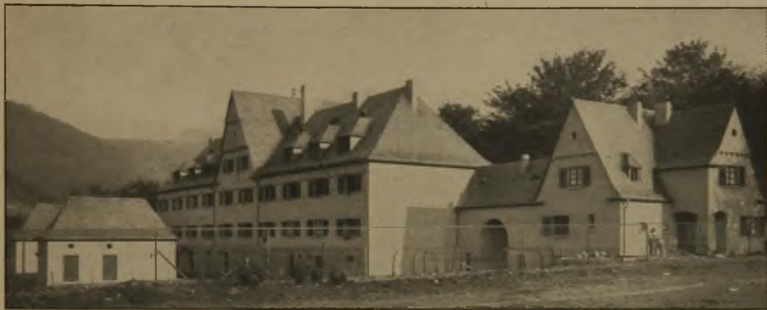
Abb. 26. Blick gegen die Rückseite der Baugruppe.
