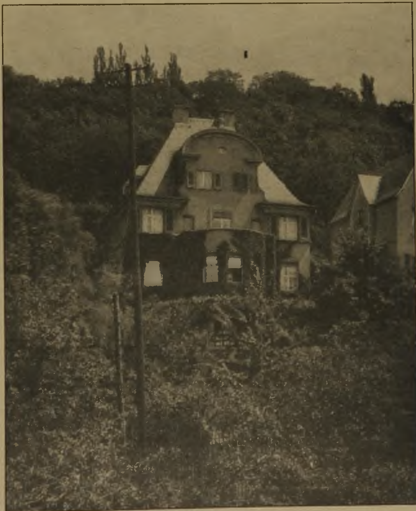
Abb. 14. Wohnhaus am Kaisersberg. Ansicht gegen das Rhein- und Ahrtal.
