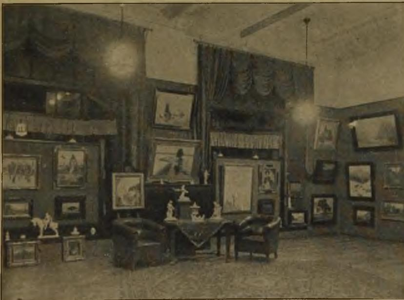
Abb. 1. Beleuchtung einer Galerie durch diffuse Tiefstrahler.
