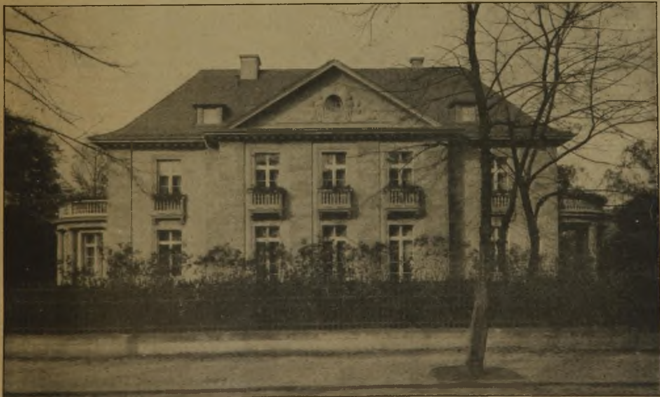
Abb. 1. Haus T. in Berlin-Charlottenburg. Fassade an der Berliner Straße.
