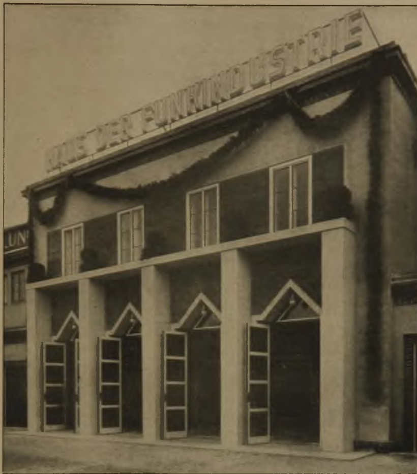
Abb. 5. Eingangshalle des Radiomeßhauses im Äußeren. Architekt: Professor Heinrich Straumer, Berlin.
