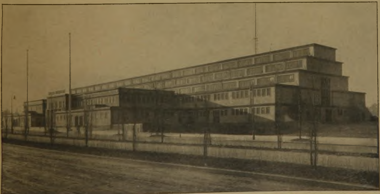
Abb. 1. Die Hauptansicht der Radiomeßhalle in Charlottenburg von Nordosten gesehen. Architekt: Professor Heinrich Straumer, Berlin.
