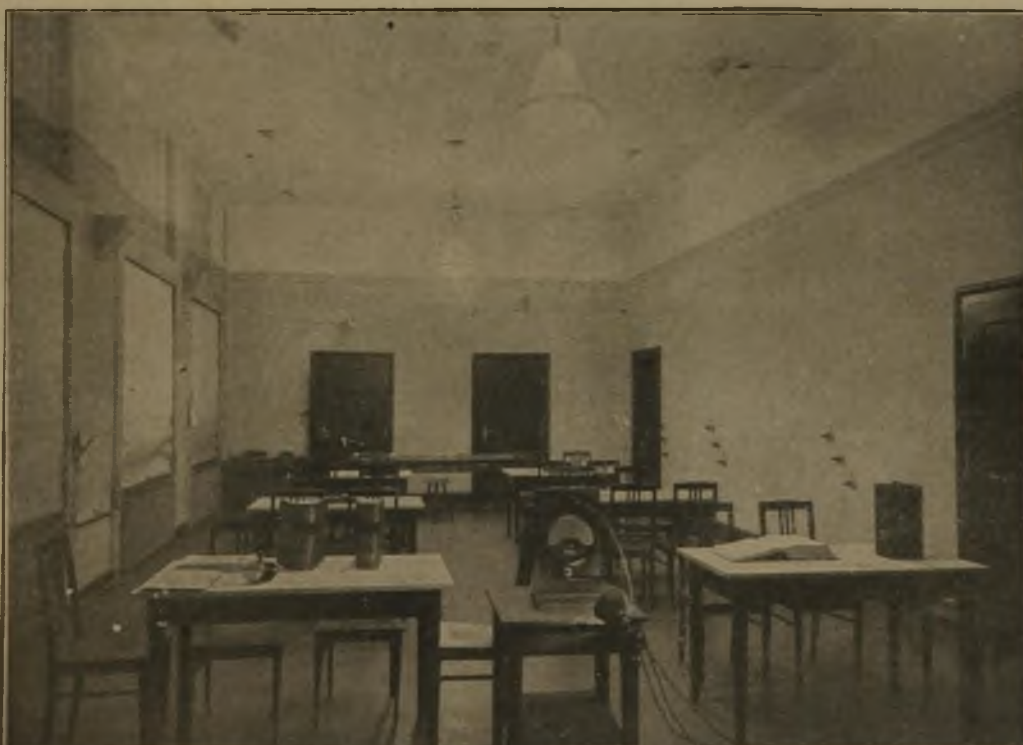
Abb. 27. Zehn kleine nackte Glühlampen: Beleuchtung unschön, blendend, für die Tische ungleichmäßig, scharfe Schatten, unwirtschaftlich (bei 1000 Watt etwa 70 Lux mittl. Beleuchtung).
