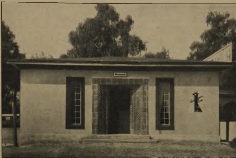
Abb. 17. Türeinfassung an der Halle der Ostmarkenschau in Frankfurt a. O.
