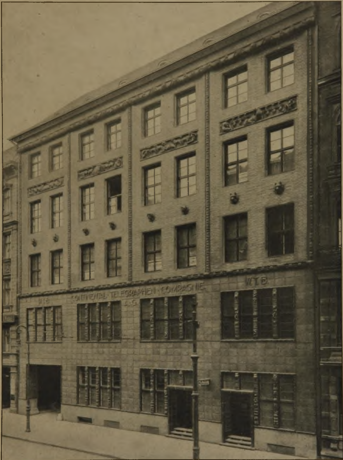
Abb. 11. Fassade des Wolff'schen Telegraphenbüros in Berlin. Ausführung der Verkleidung Ullersdorfer Werke, Niederullersdorf, Kreis Sorau. Die Keramik in der modernen Baukunst.
