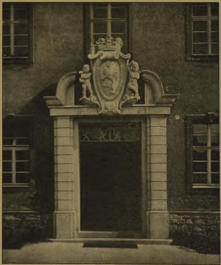
Abb. 1. Haupteingang des neuen Stadthauses.
