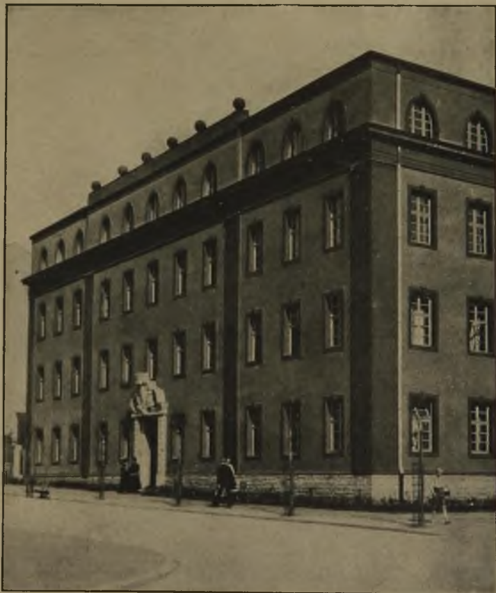
Abb. 6. Die ehemalige Kaserne, jetzt Stadthaus, nach dem Umbau.
