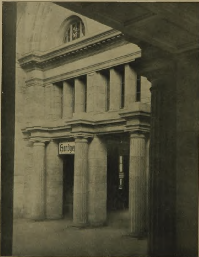
Abb. 5. Außenfassade. Stirnseite Querbahnsteig.
