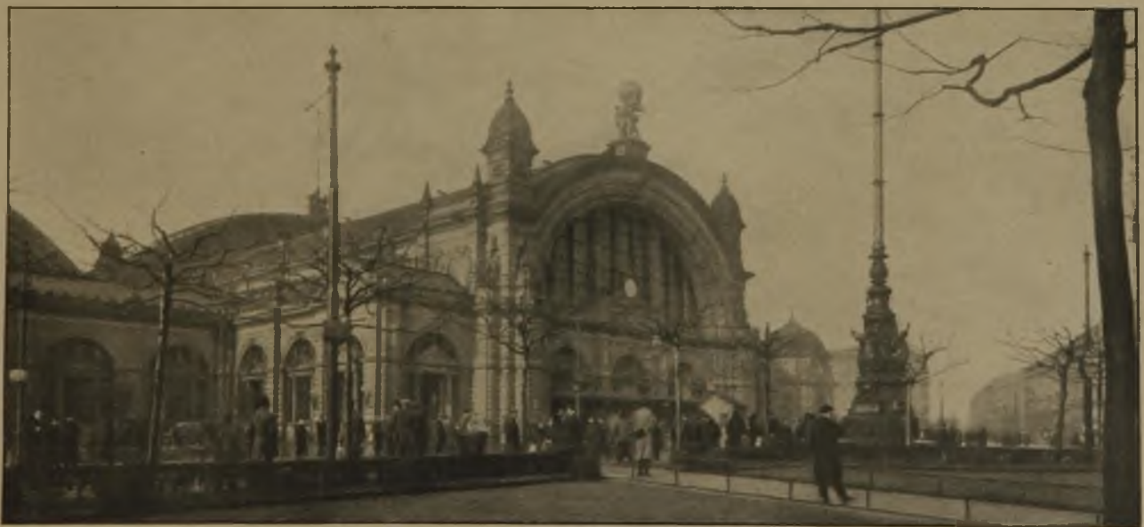
Abb. 1. Blick auf den Hauptbahnhof vom Bahnhofsplatz aus. (Vor dem Umbau.) Architekt des alten Bahnhofs: Hermann Eggert.
