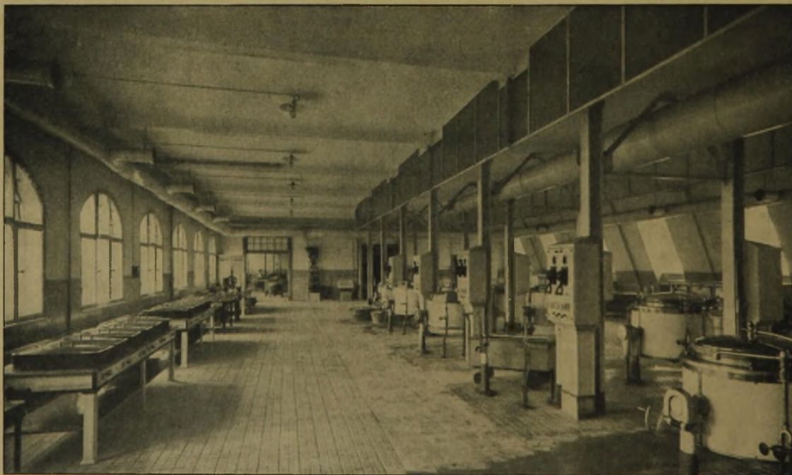
Abb. 10. Küchenraum der Kasino-Anlage im Dachgeschoß. Verwaltungsgebäude des Siemenskonzerns in Siemensstadt. Architekt: Regierungsbaumeister a. D. Hertlein, Berlin-Westend.
