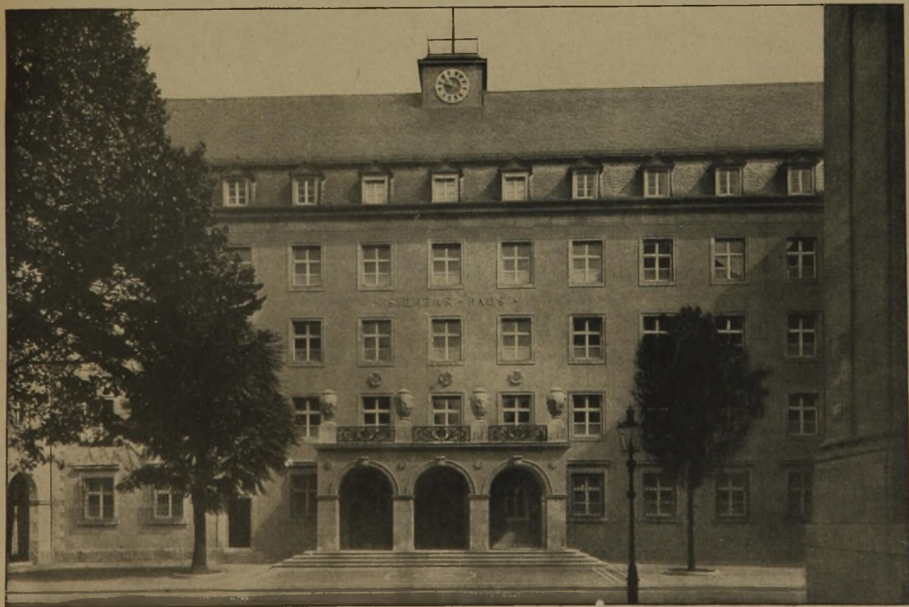
Abb. 16. Siemens-Haus in Mannheim, Hauptfront. (Vgl. die Abb. 17—19 auf S. 274.) Architekt: Regierungsbaumeister a. D. Hertlein, Berlin-Westend.
