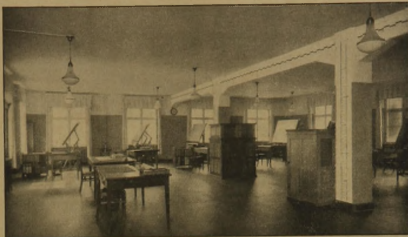
Abb. 34 (oben). Arbeitssaal. Abb. 35 (Mitte). Speise- und zugleich Vortragssaal im Dachgeschoß.
