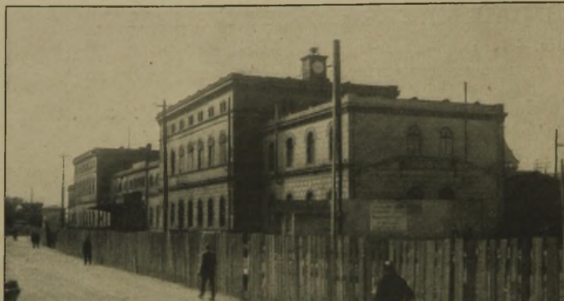
Abb. 2. Altes Bahnhofsgebäude kurz vor Abbruch.
