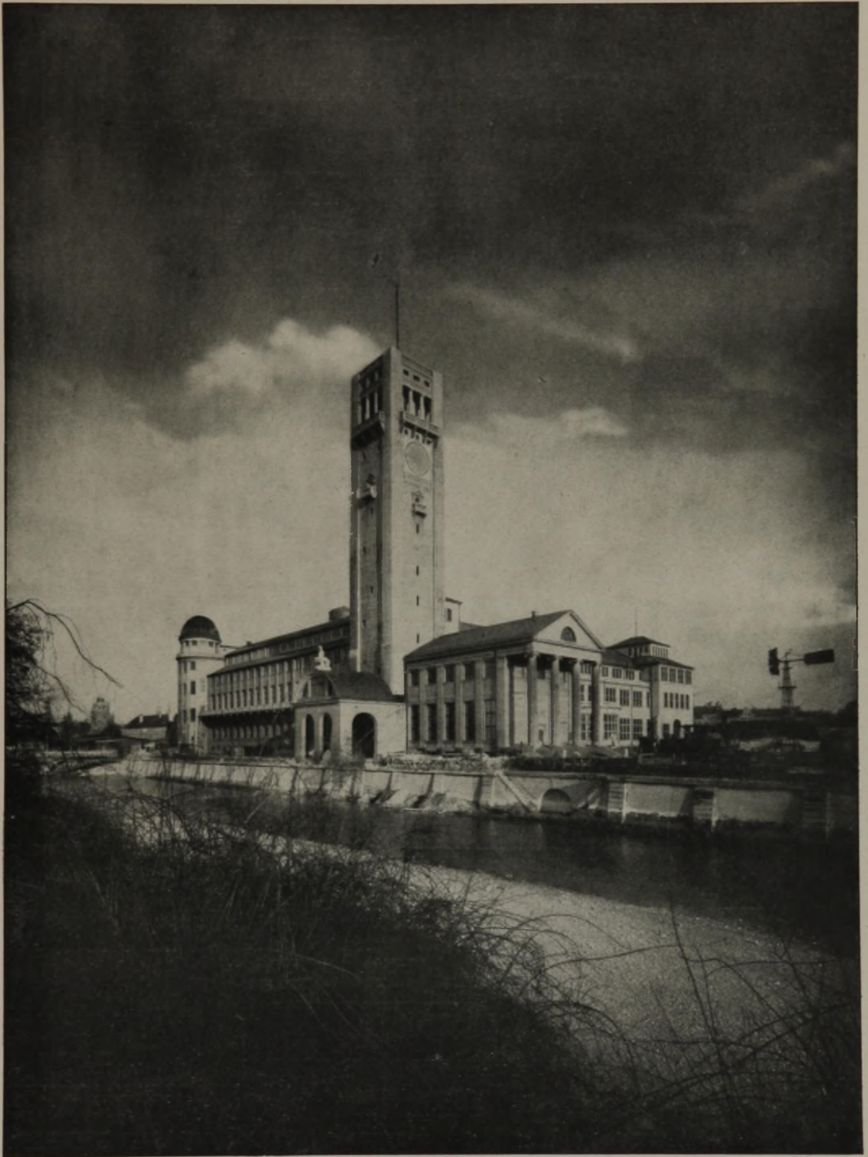
DAS DEUTSCHE MUSEUM IN MÜNCHEN / AUSSTELLUNGSBAU ARCHITEKTEN: PROF. GABRIEL VON SEIDL U. PROF. EMANUEL VON SEIDL DEUTSCHE BAUZEITUNG. LIX. JAHRGANG 1925. NR. 37
