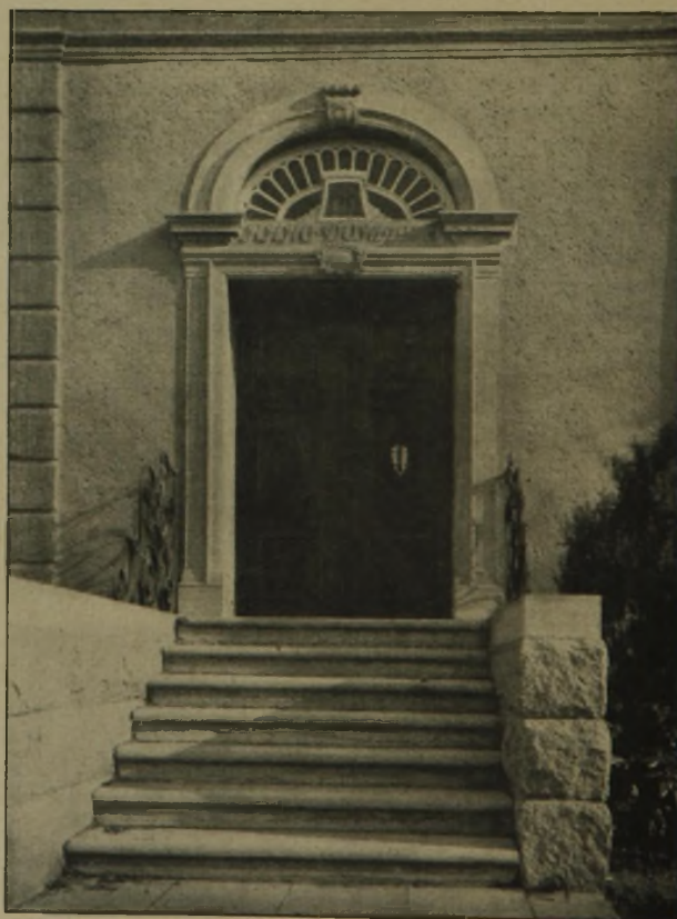
Abb. 13. Haupteingang des Landhauses Adler.
