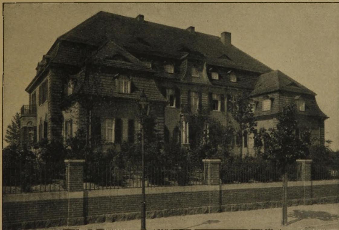
Landhaus Heydenreich in Berlin-Dahlem. Arch. B. D. A. Ernst u. Reg.-Baumstr. Dr.-Ing. Günther Paulus. Neuere Villenbauten.
