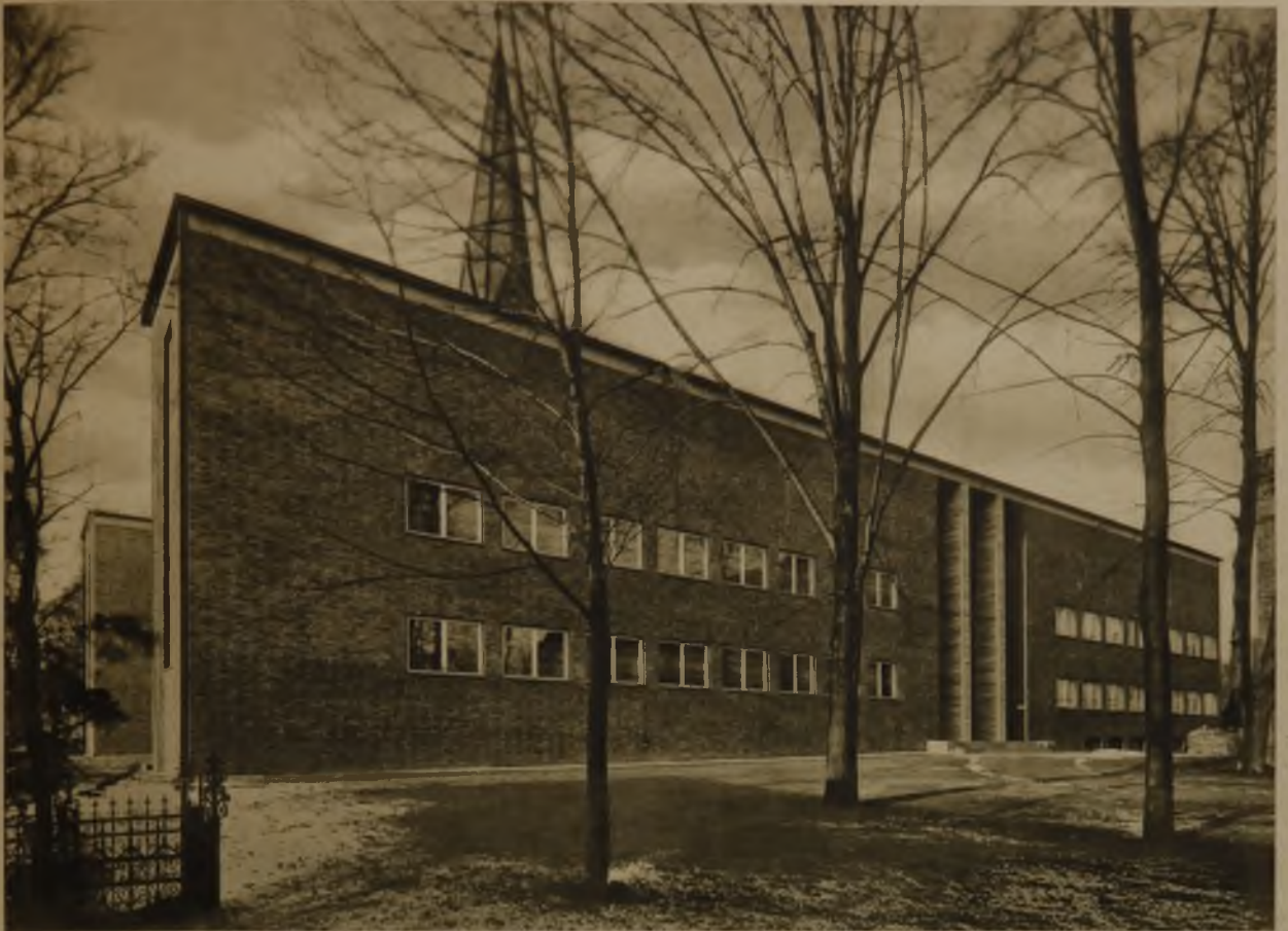
Hauptansicht an der Schloßstraße
