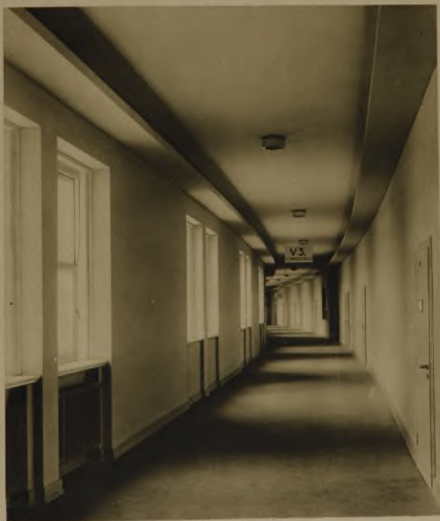
Der gebogene Flur im Längsbau. Über dem Plattengesims liegen, unverkleidet, die Rohrleitungen
