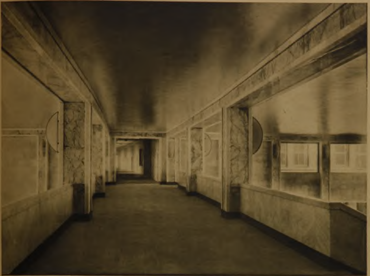
Flur des I. Obergeschosses im Hauptgebäude. (Quer durch die Halle)
