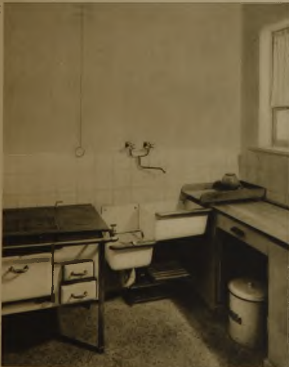
Großsiedlung Bad Dürrenberg. Außenganghaus-Mietswohnung. Küche mit eingebauten Möbeln, kombinierten Spül- und Ausgußbecken. (Vgl. Abb. 5)
