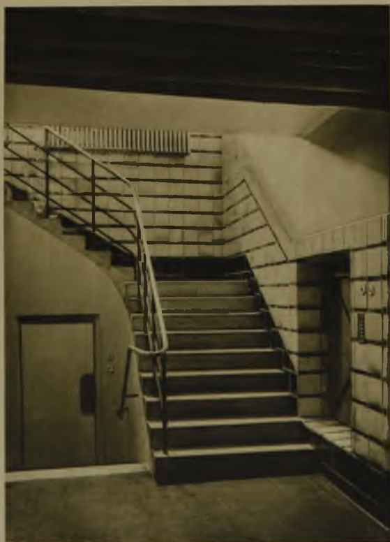
Nebentreppe zum Untergeschoss
