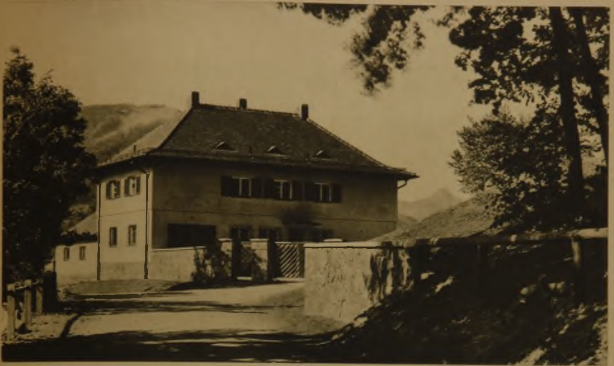
Nebengebäude mit Einfahrt. — Mauer aus rotem Marmor vom Platz
