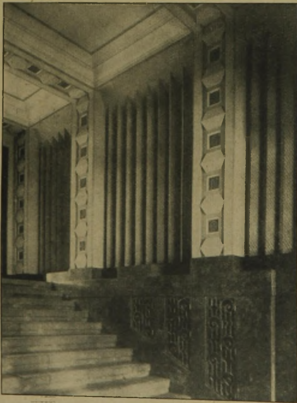
Abb. 9. Heizkörperumrahmung im Flur des IV. Obergeschosses.
