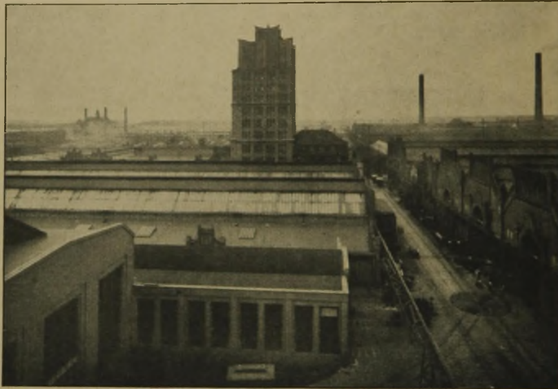
Abb. 1. Das Turmhaus inmitten der Werksanlagen.
