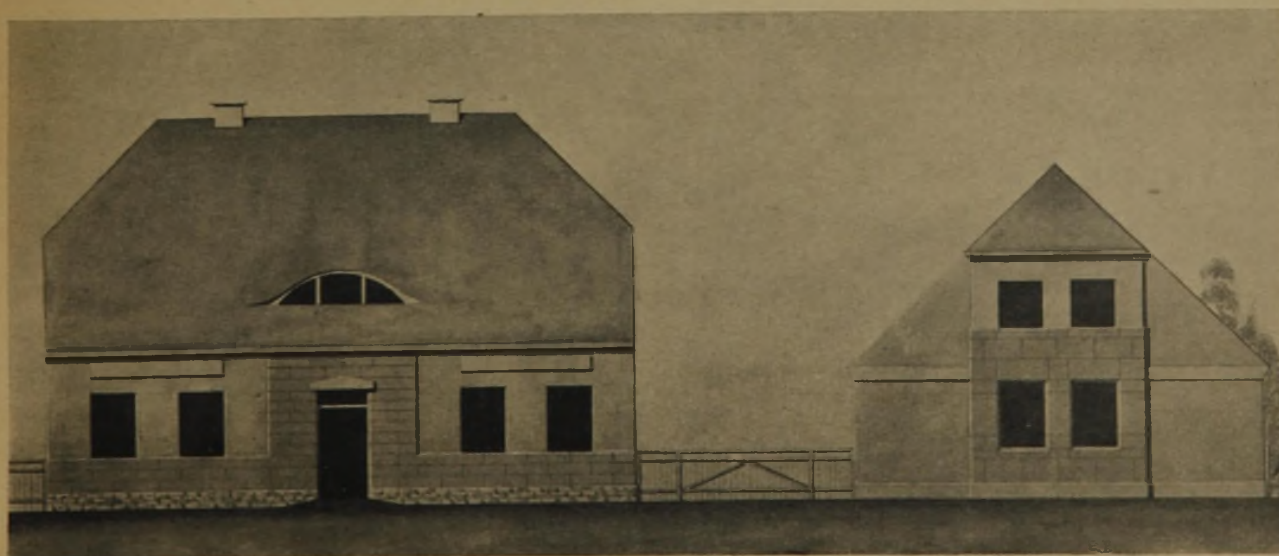
Abb. 9. David Gilly. Paretz, Wohnhaus und Stall des Kossäten Scharbrock.
