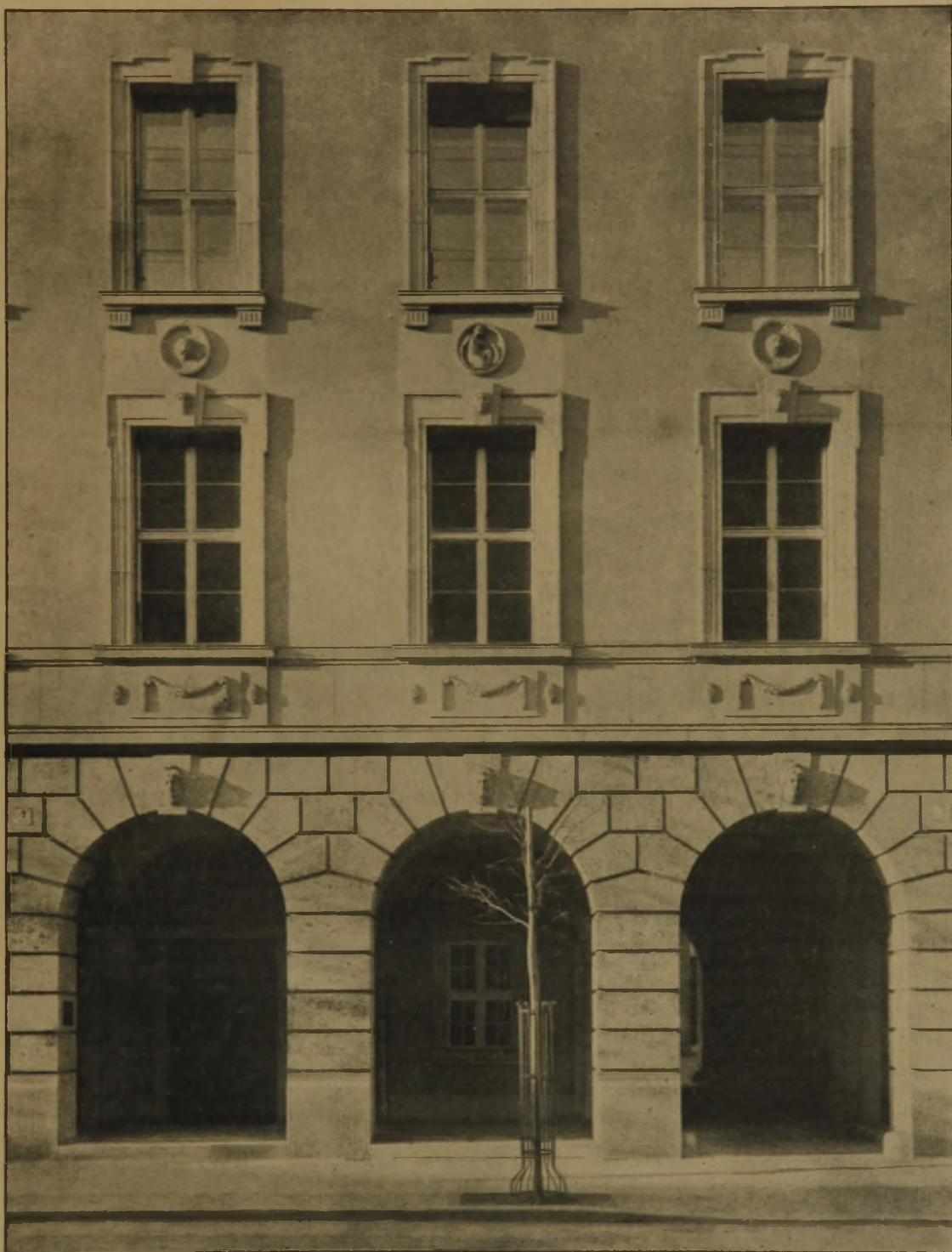
Abb. 12. Fassadenteil des Mittelbaues mit dem Haupteingang. Arch.: Reg.-Baumstr. Hans Hertlein. Bildlicher Schmuck: Prof. Rauch †.
