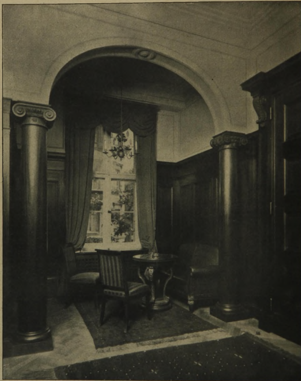
Abb. 18. Nische im Vorzimmer. Das Siemenshaus in Berlin.
