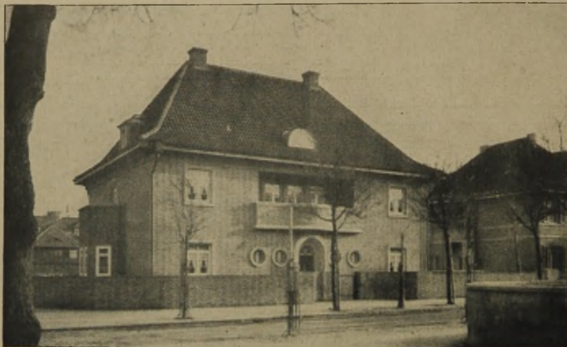
Abb. 2. Oberstenhaus. Architekt: Baurat Niggemeyer, Köln.
