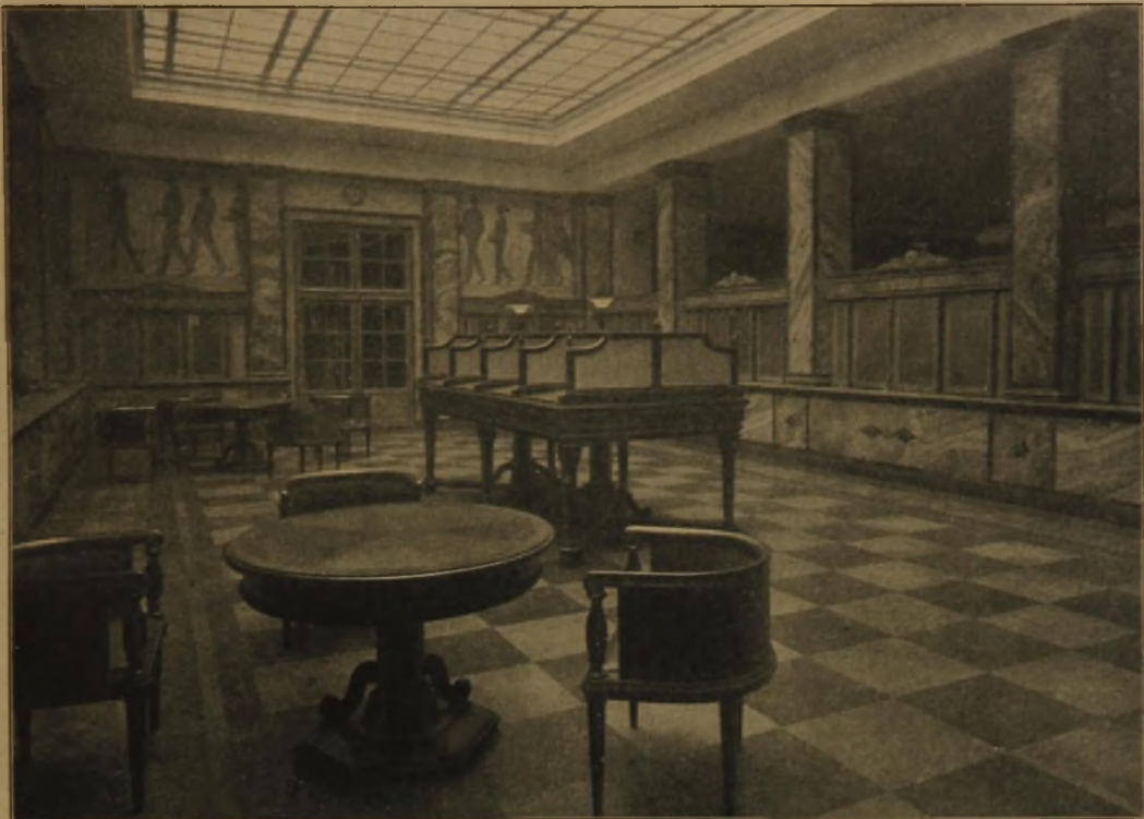
Abb. 7. Kassenhalle. Architekten: Pfeifer & Großmann.
