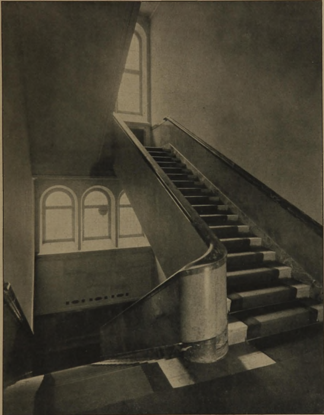
Abb. 14. Treppenaufgang zum Direktorengeschoß.
