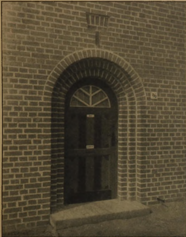
Abb. 14. Haustür in der städtischen Siedlung in Hannover-Laatzten.
