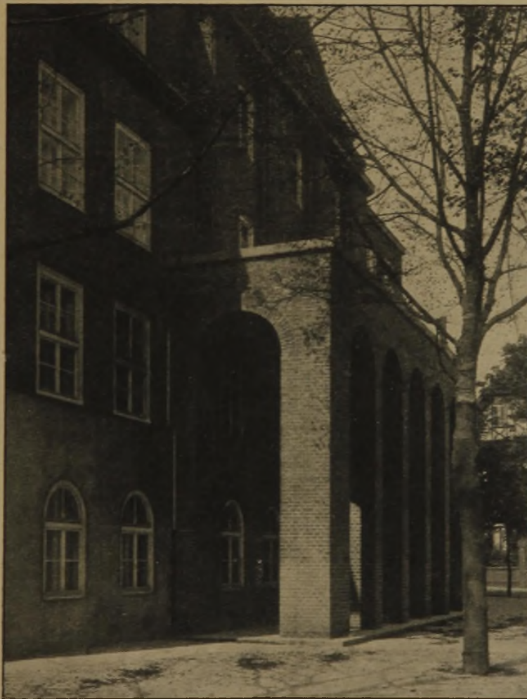
Abb. 1. Nordflügel mit Eingang an der Friedrichstraße.
