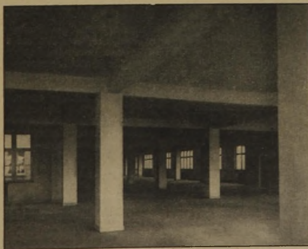
Abb. 13. Blick vom Turm-Innenraum im Seitenflügel.
