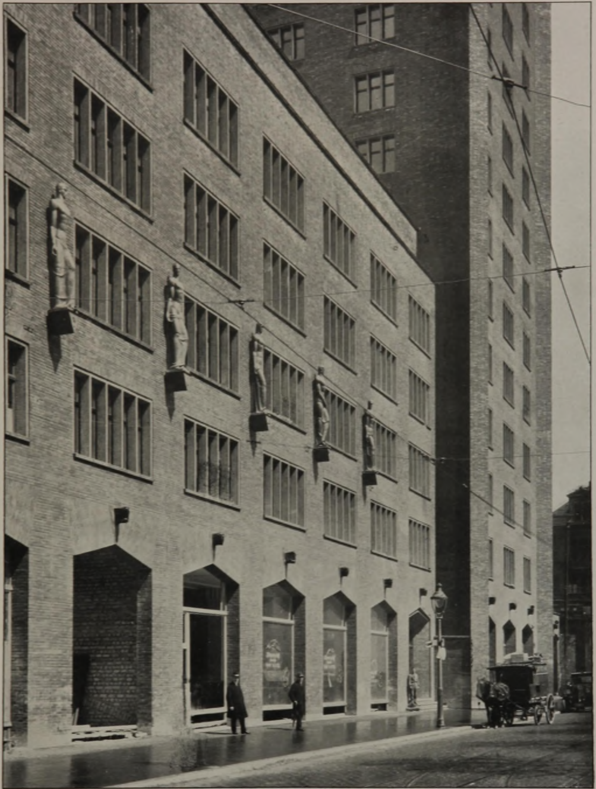
DAS HOCHHAUS AM HANSARING IN KÖLN TEILANSICHT AM HANSARING MIT KERAMISCHEN PLASTIKEN ARCHITEKT: JAKOB KOERFER, KÖLN DEUTSCHE BAUZEITUNG. LIX. JAHRGANG 1925. NR. 67
