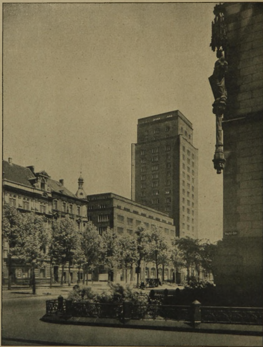
Abb. 8. Ansicht des Hochhauses am Hansaring.
