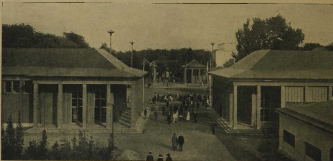
Abb. 9. Hallen des Sächs. Handwerks. Arch. Ratszimmermstr. Ernst Noack, Dresden.
