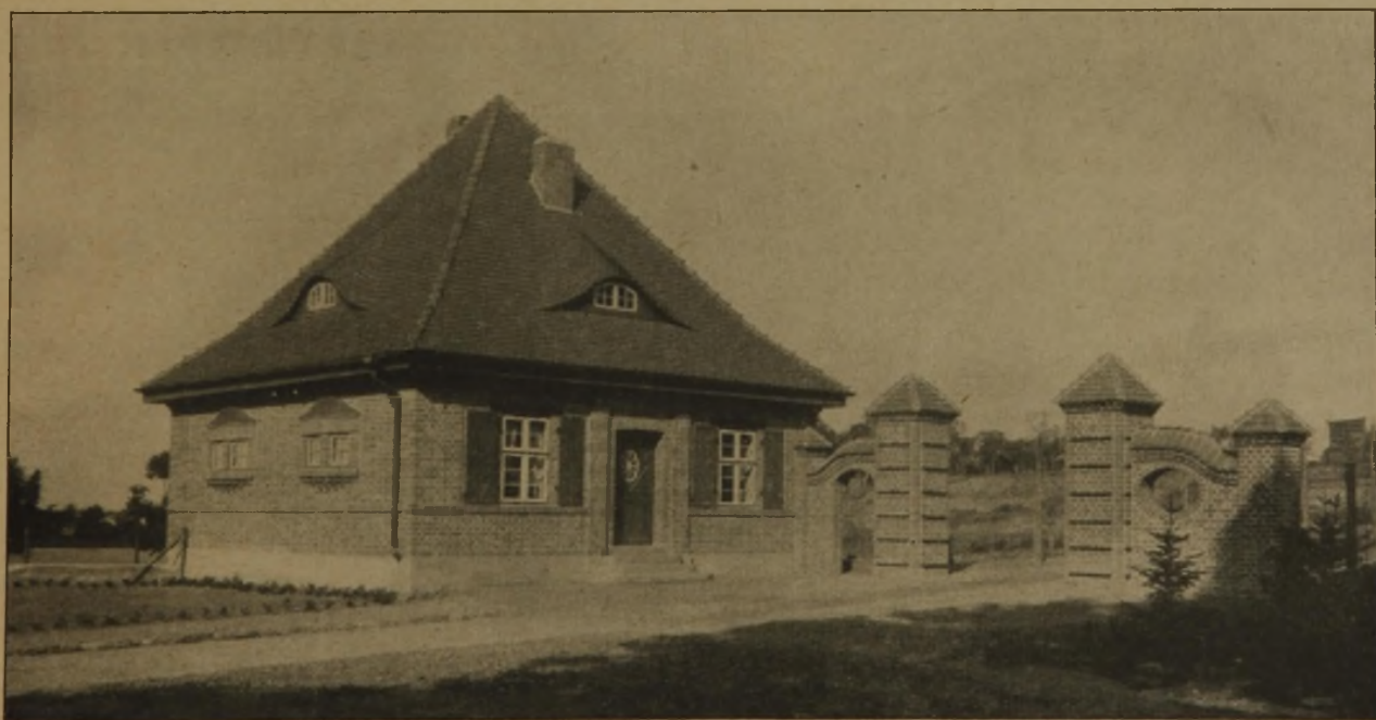
Abb. 21. Einfahrt und Verwalterwohnhaus des Friedhofes.
