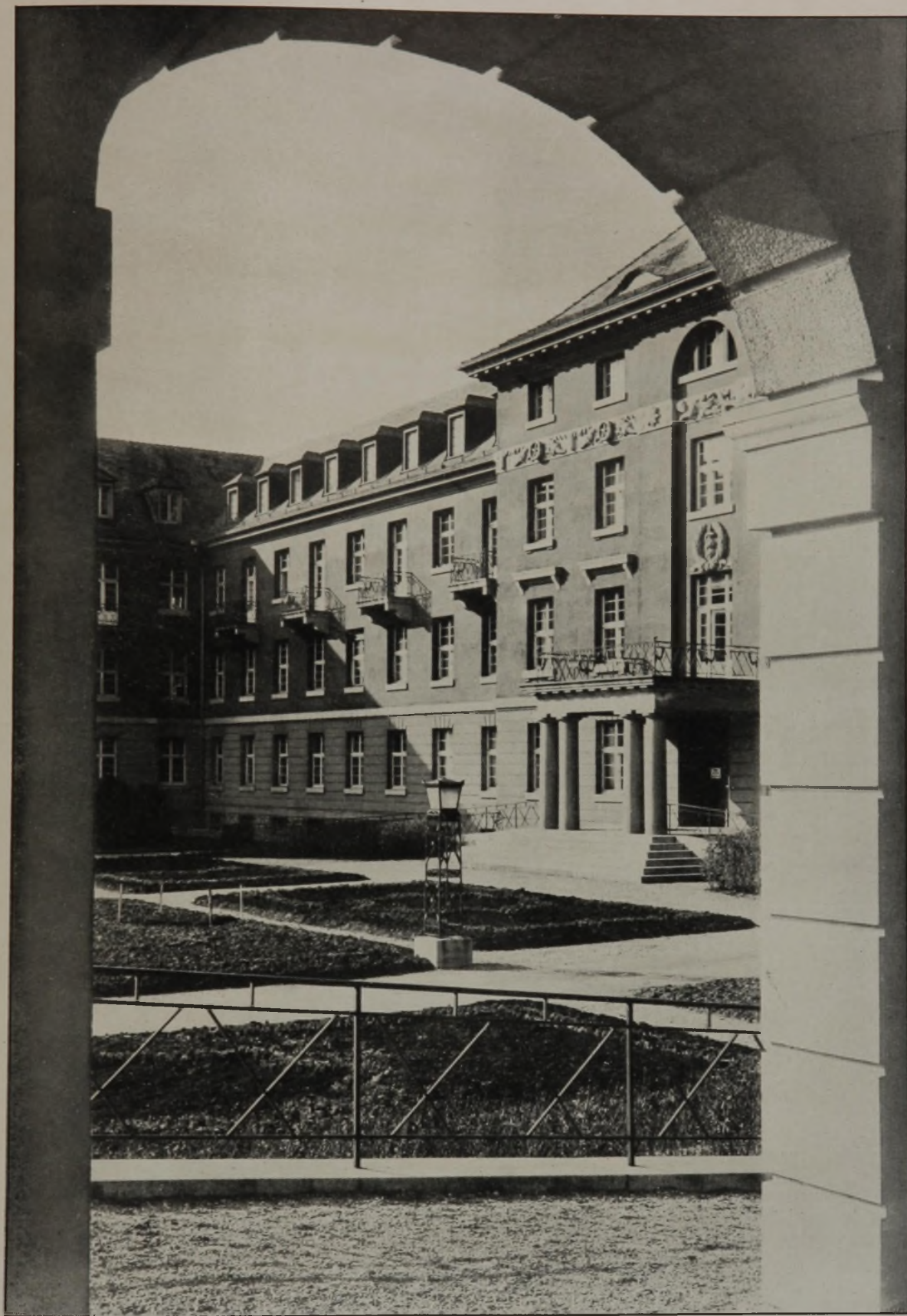
DIE NEUE MEDIZINISCHE KLINIK DER UNIVERSITÄT HEIDELBERG BLICK VON DER LIEGEHALLE DES ERDGESCHOSSES NACH DEM MITTELBAU ARCHITEKT: OBERBAURAT DR. h. c. LUDWIG SCHMIEDER / HEIDELBERG DEUTSCHE BAUZEITUNG. LIX. JAHRGANG 1925. NR. 71
