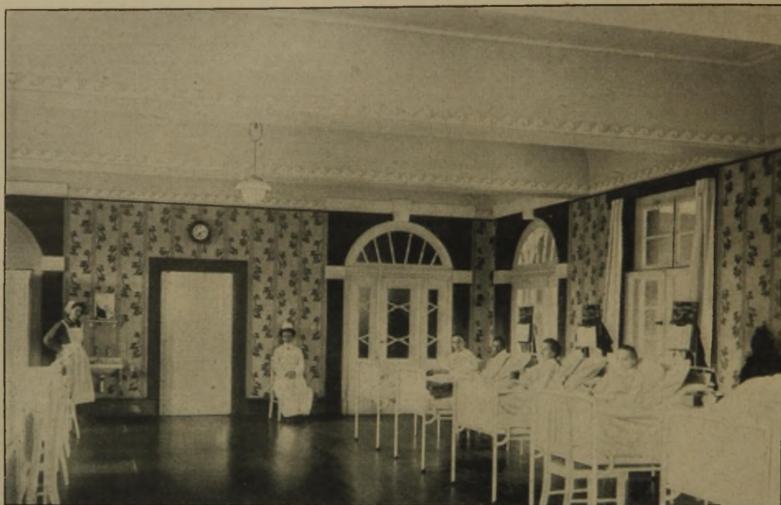
Abb. 4. Blick in einen Krankensaal im 2. Obergeschoß.
