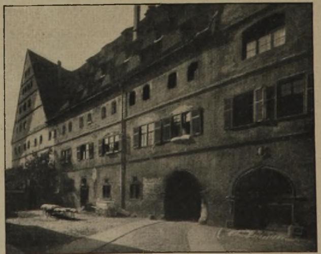
Abb. 4. Der „Neue Bau“ in Ulm. Nach Aufnahmen der staatl. Bildstelle, Berlin.
