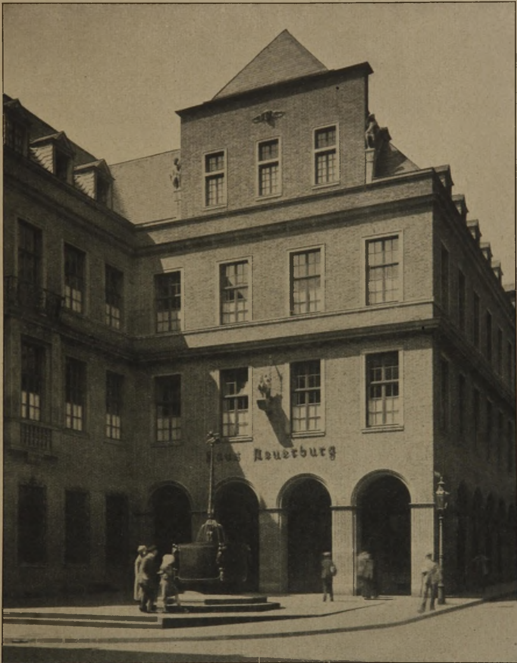
Abb. 5. Teilansicht der Fassade am Gülichplatz.
