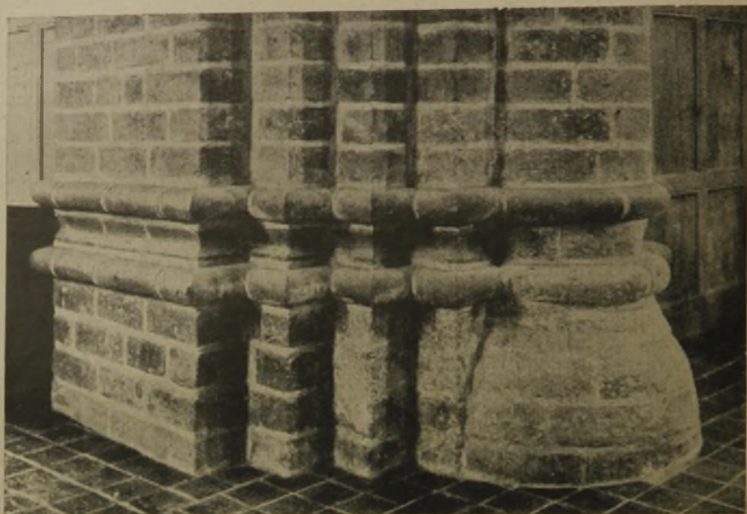
Abb. 9. Portalsockel von der Südseite.
