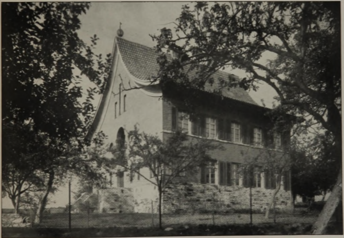
AUS DER BAUKÜNSTLERISCHEN TÄTIGKEIT DES ARCHITEKTEN FRITZ VOGGENBERGER †, FRANKFURT AM MAIN OBEN: HAUS POLLATSHECK / FORSTHAUSSTRASSE FRANKFURT AM MAIN UNTEN: LANDHAUS PADERSTEIN / HOFHÄUSEL BEI EPPSTEIN IM TAUNUS DEUTSCHE BAUZEITUNG. LIX. JAHRGANG 1925. NR. 77
