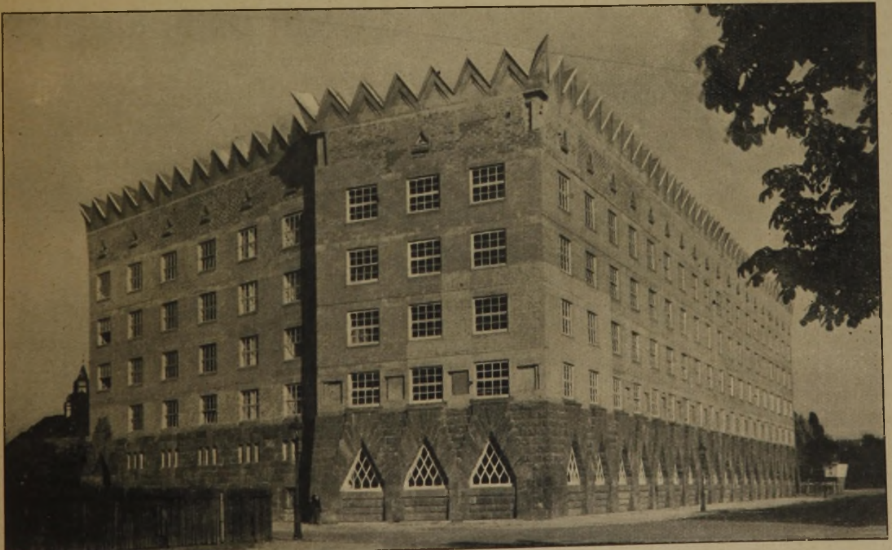
Abb. 1. Geschäftshaus Fritz Vogel & Co. in der Nähe des Hauptbahnhofes zu Frankfurt a. M.
