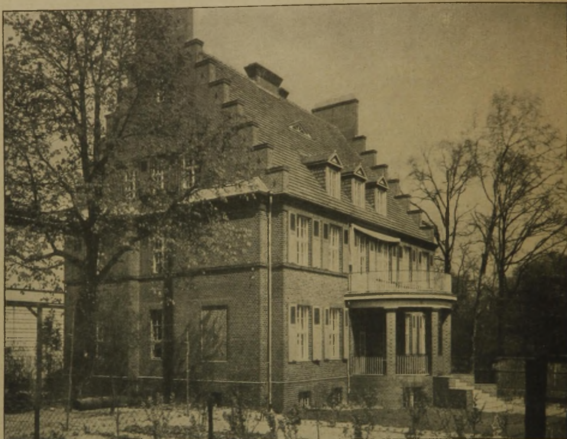
Abb. 6. Blick auf das Landhaus aus dem rückwärtigen Nachbargarten.
