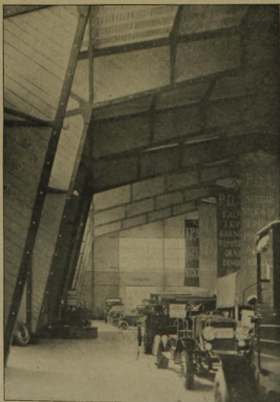
Abb. 3. Inneres der Autohalle. Holzkonstruktion. Künstl. Oberleitung Prof. O. O. Kurz, München. Konstr.- Entwurf Fa. Kübler, Stuttgart. Stat. Berechnung Ob.-Ing. Gall. (Phot. Reg.-Baumstr. Müller, München.)
