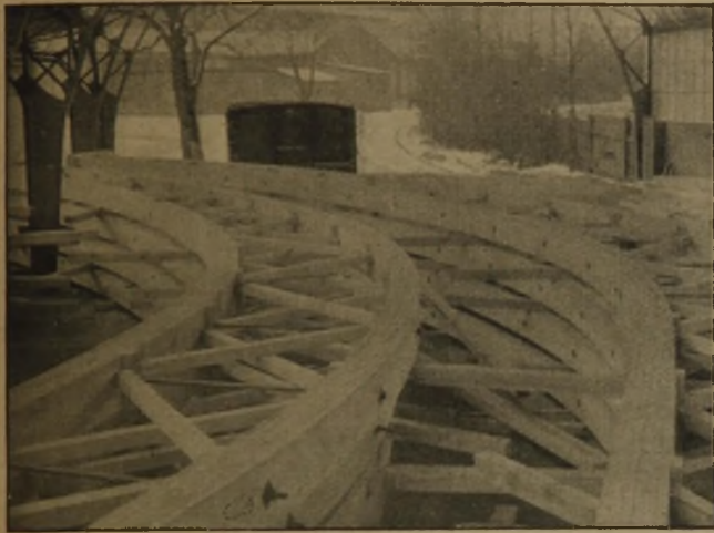
Abb. 18. Bogenbinder der Halle für Luftfahrt. Zur Montage bereit.
