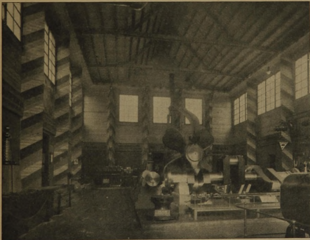
Abb. 6. Inneres der Halle IIa. Schiffsmaschinen, Holzkonstruktion. Arch. Rg.-Bmstr. Danzer. (Phot. Stark, München.)
