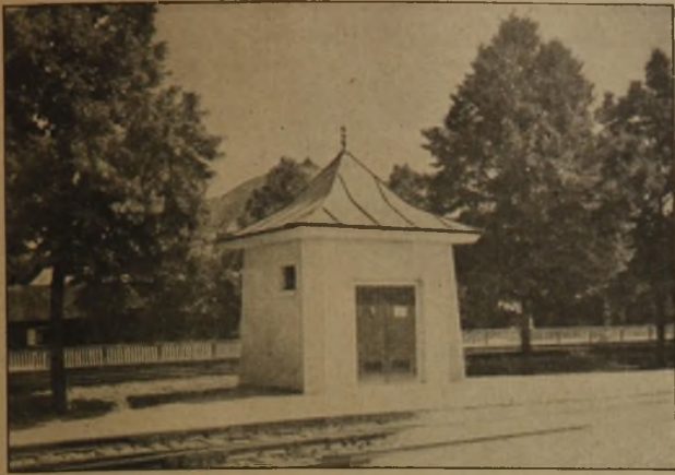
Abb. 16. Transformatorenhäuschen im Ausstellungs-Bahnhof. Arch. u. Phot. Reg.-Bmstr. Müller-Grah, München.
