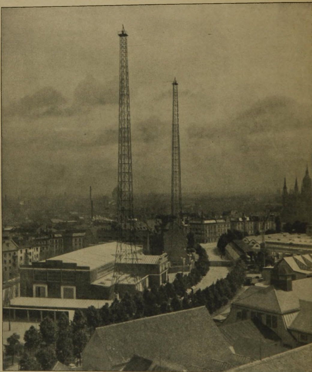
Abb. 7. Gesamtbild der Halle mit den beiden Rundfunktürmen. Die Halle für Krafffahrwesen und Rundfunksender auf der Verkehrsausstellung in München 1925.
