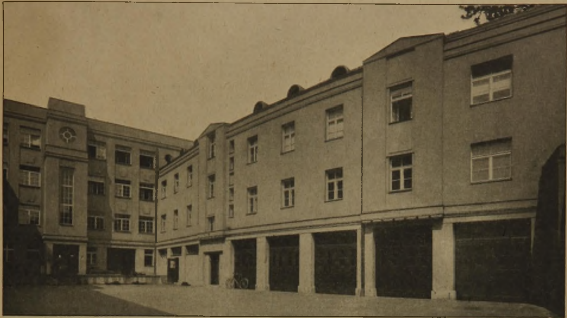
Abb. 11. Blick in den Hof gegen Hintergebäude u. Seitenflügel.
